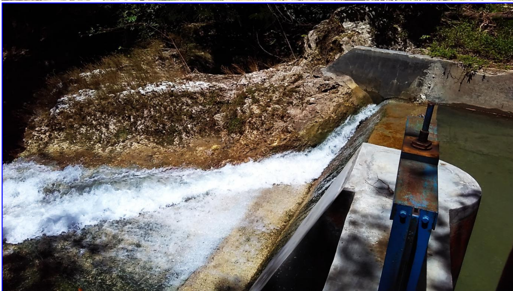
Gambar 9. Fasilitas PLTMH Mbakuhau
