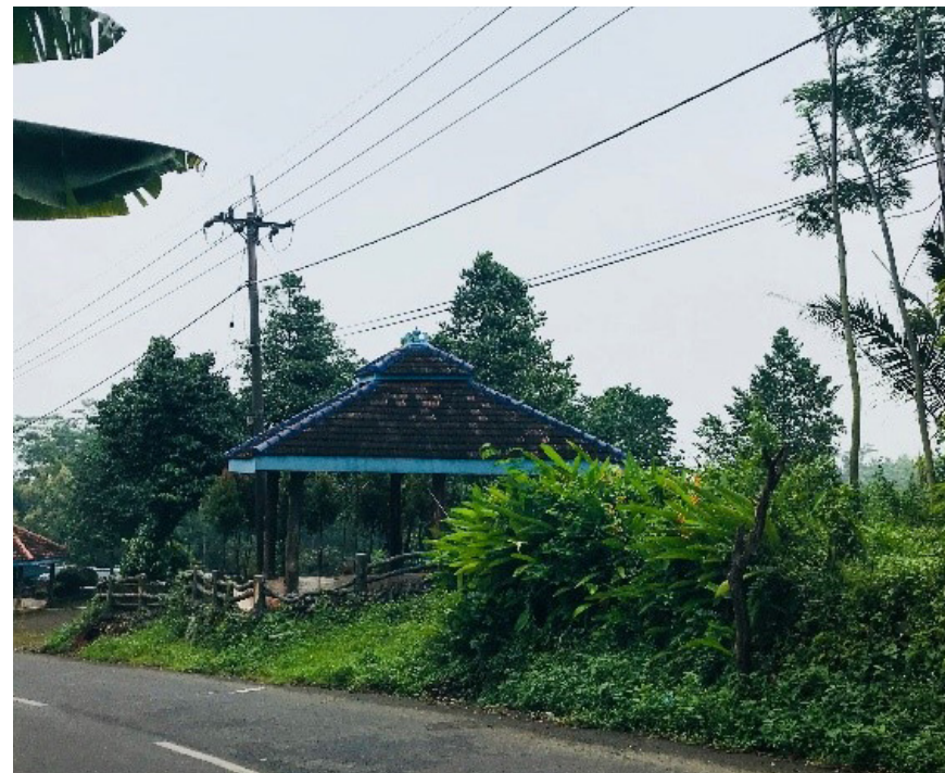
Fasilitas dan jaringan PLTMH Kalimantan dan PLTMH Wot Lemah
