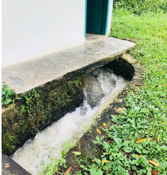
Fasilitas dan jaringan PLTMH Kalimantan dan PLTMH Wot Lemah
