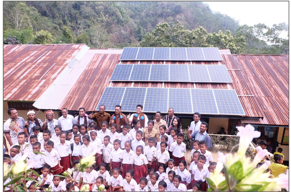
Instalasi PLTS Atap untuk sekolah dasar di Boafeo, Ende, NTT
