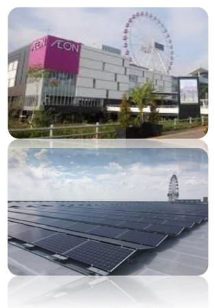
AEON Mall Cakung memanfaatkan PLTS Atap dengan kapasitas 500 kWp untuk sistem penerangan
