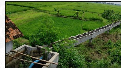
Pada Tahun 2020 telah dibangun Pompa Air dengan Tenaga Surya tanpa baterai di Desa Kaliwungu Lor, Kecamatan Ngombol, Kabupaten Purworejo untuk mengairi lahan pertanian (sawah) seluas 18 ha dengan menaikan air dari sungai dengan pompa bersumber dari energi matahari dengan kapasitas 11 KWp.
