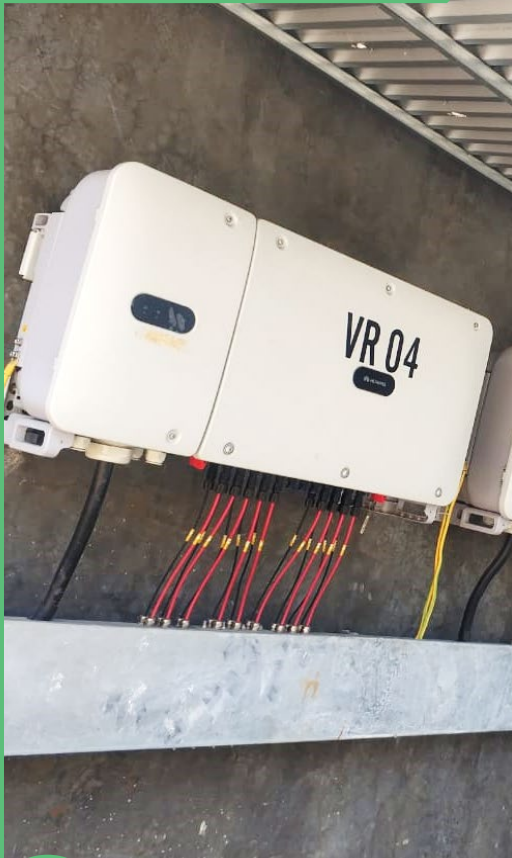
Penempatan Inverter
