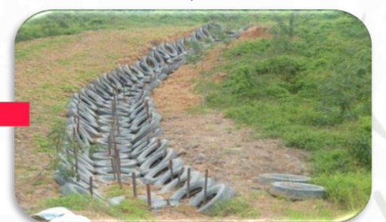
Pembuatan saluran drainase dan pengendalian erosi
