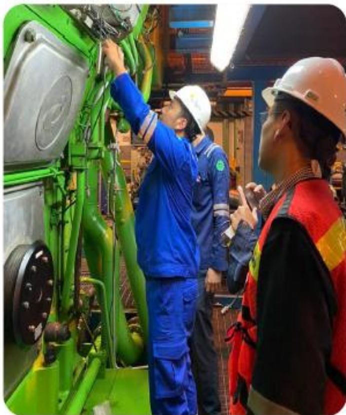
Tidak terdapat kerusakan saat pelaksanaan uji
